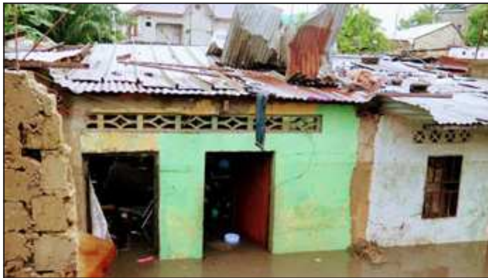
Les secouristes ont dû créer une ouverture sur la toiture pour tirer les corps sans vie des cinq enfants d'une même famille (Photo Radio Okapi)
