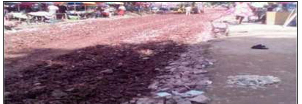
Une vue des travaux de réhabilitation de l'avenue Colonel Ebeya (Photo Déborah Mangili)
