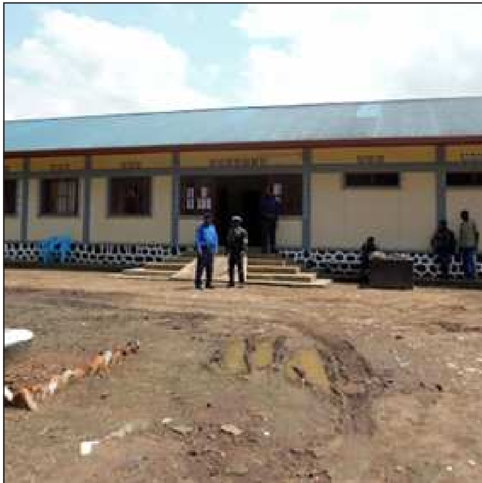
Le bureau du district de la Police nationale congolaise réhabilité à Rutshuru (Nord-Kivu) dans le cadre des projets à impact rapide de la Monusco.
