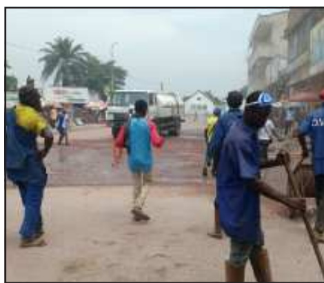
Les ouvriers chargés d'effectuer les travaux de renforcement du goudron sur l'avenue du Commerce (Photo Deborah)
